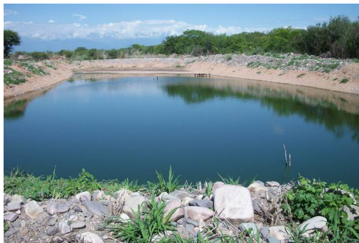
Figura 5: Aspecto de la Laguna 2 al final del proceso de maduración.
