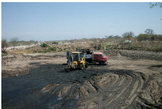
Figura 3: Proceso de extracción del lodo sedimentado de la Laguna (1).
